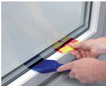
Установка подкладки
