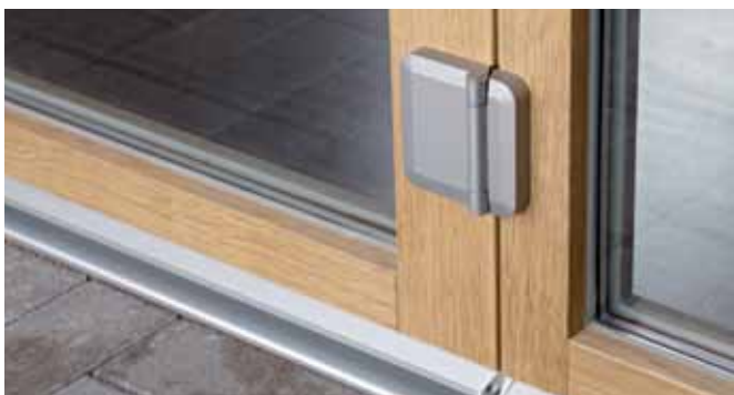
Повышенная противовзломность благодаря скрытому креплению шарнирных петель
